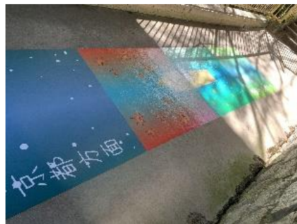
写真：上下線を結ぶ通路
